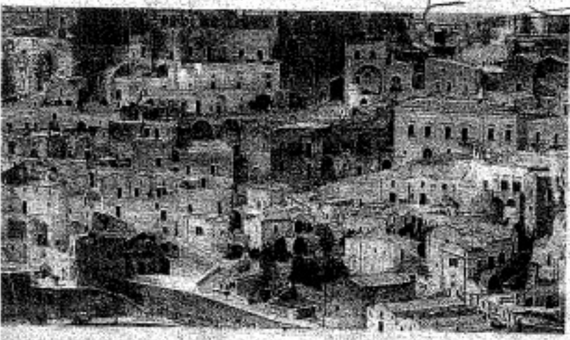
RIANI SASSI Uno scorcio del suggestivo insediamento che nei millenni ha preso forma nella tenera calcarenite della Murgia
